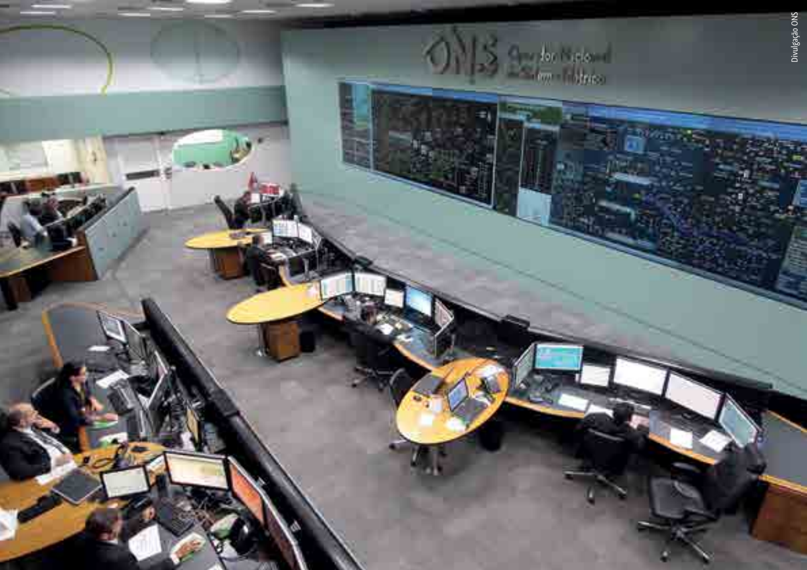
Centros de operações regionais controlam o Sistema Interligado Nacional (SIN)
